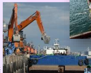
油圧ショベルで陸揚げ
