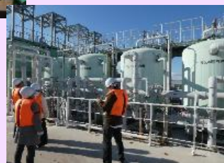
廃水処理施設
