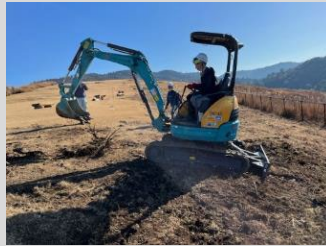
根径掘取り(機械掘取)
