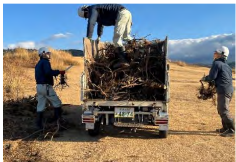
R6 施工状況
