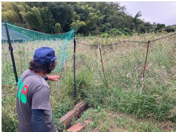
I) 水路沿いのフェンスが変形。補強しているが入口ネット同様に脆弱。
