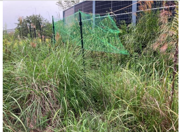
G) 斜面上から太陽光パネル下を移動してきたシカが柵を突破、補修している
