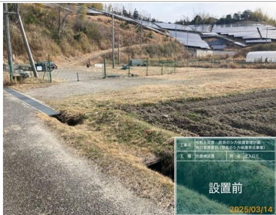
③既設柵の状況
