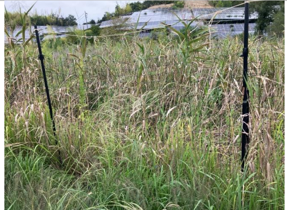
D) 7月侵入箇所を簡易補修している。
