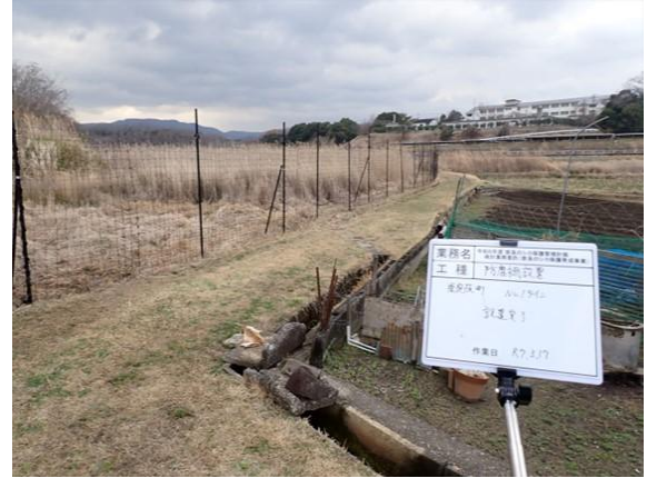
②R05-1 終点近く（施工後）
