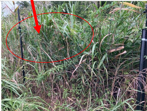
侵入箇所 F) 体重をかけフェンスを变形させ、上部から侵入している
