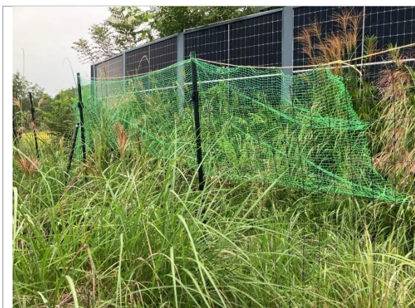
G) 内側への押し倒しによる破損にネットを張り簡易補修している。
