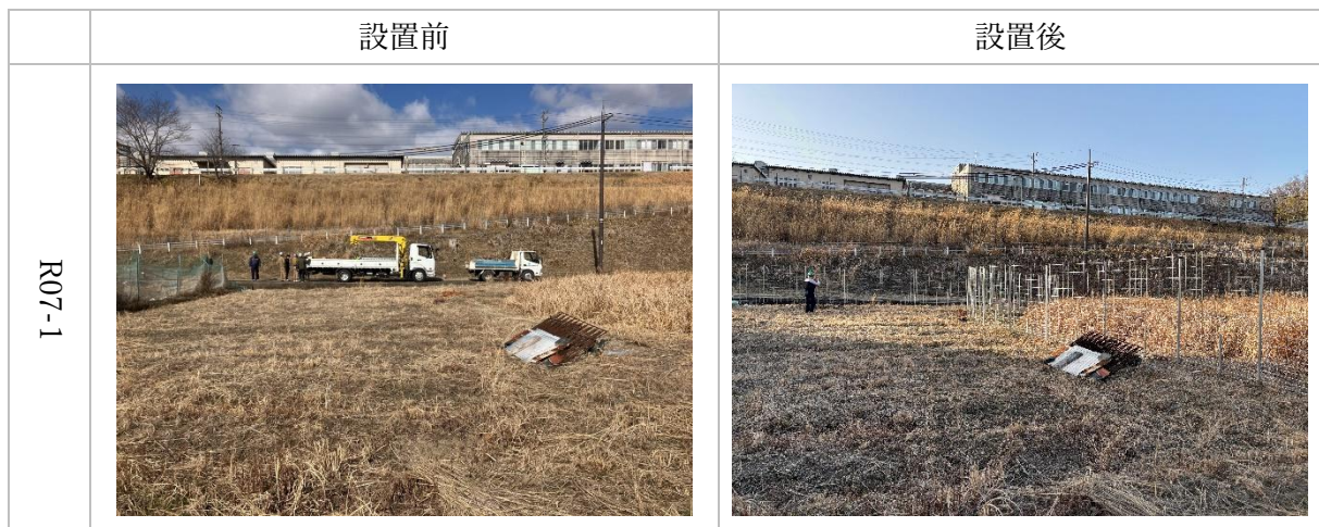
写真 1 R07-1 における設置前後の状況
