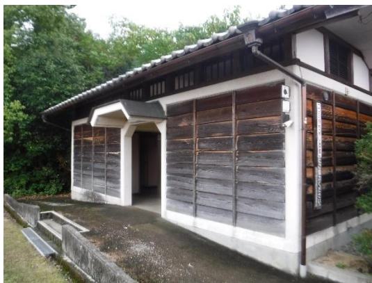
地元広場隣接の公衆トイレ（市管理）
