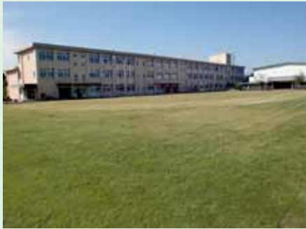
大和郡山市立治道小学校
