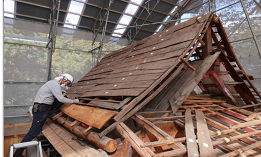
文化財建造物の保存修理の様子
