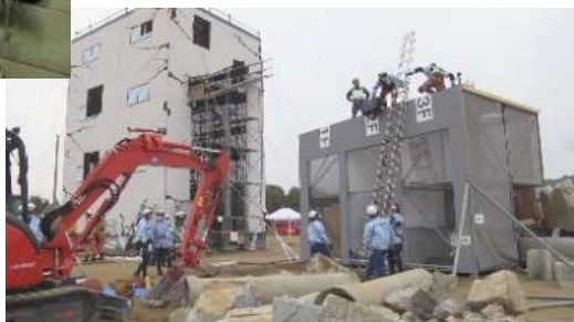
自主防犯・防災リーダー 研修の様子 倒壊ビル救出訓練の様子
