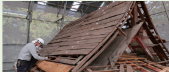
文化財建造物の保存修理の様子
