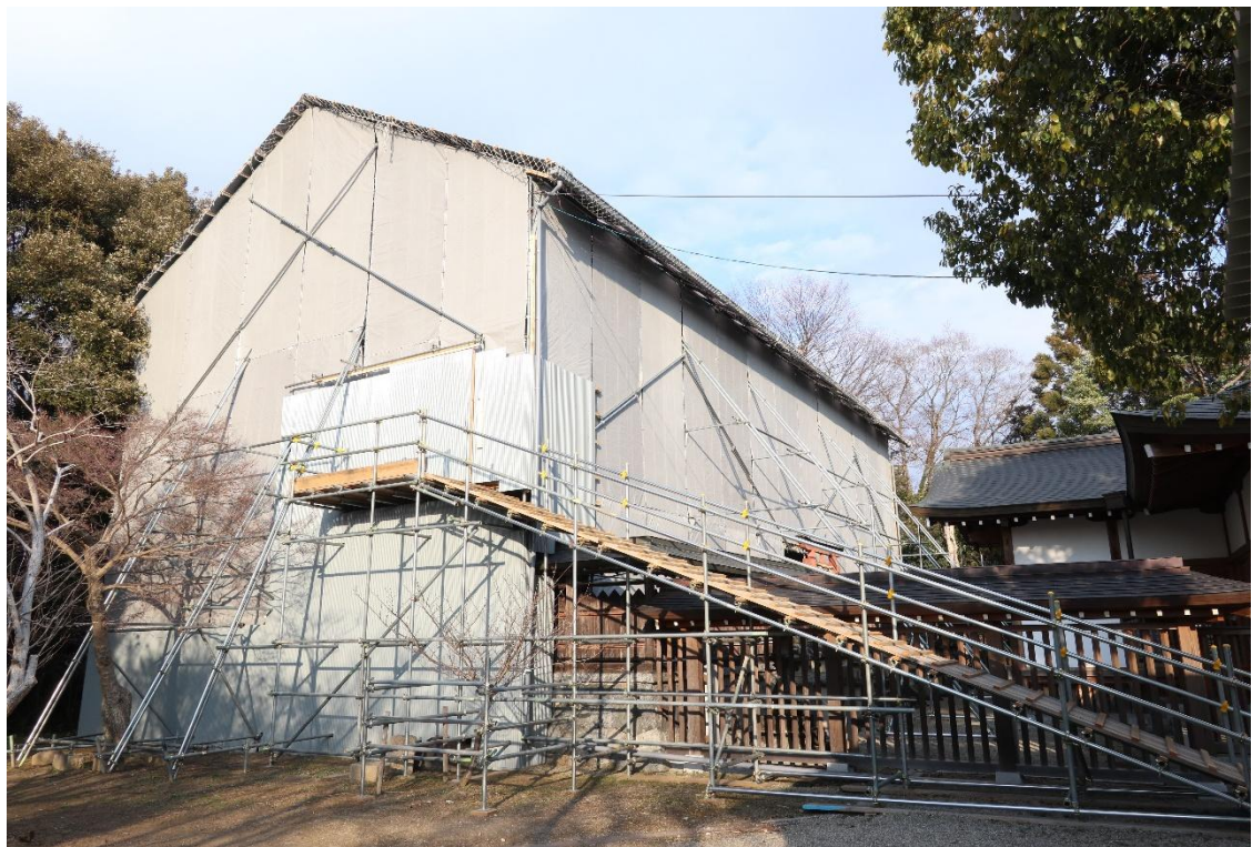
素屋根 全景（南西より）
