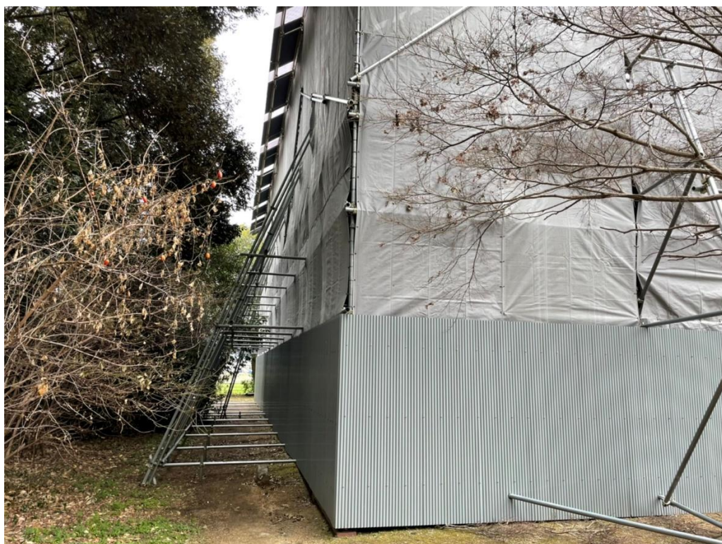
素屋根 全景（北西より）
