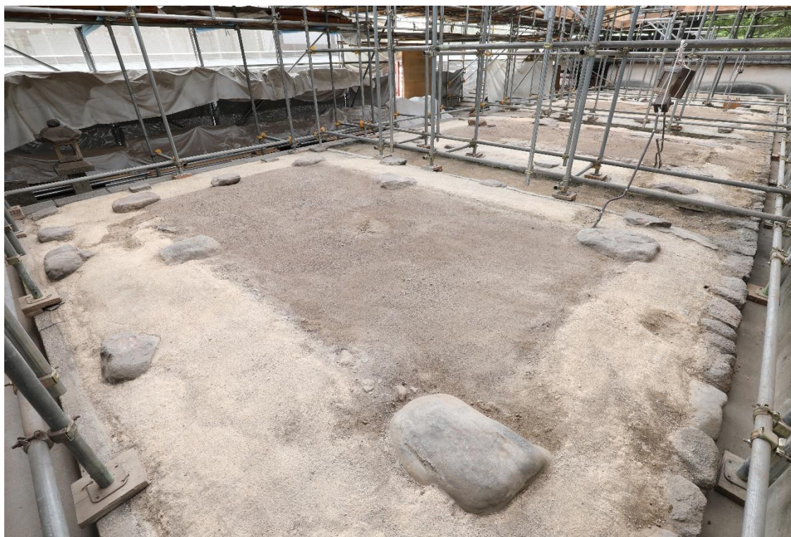
素屋根 内部 （北東より）
