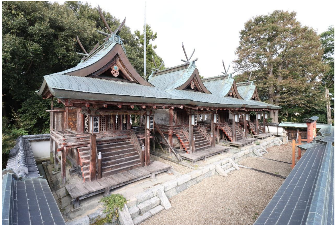
修理前全景（南西より）
