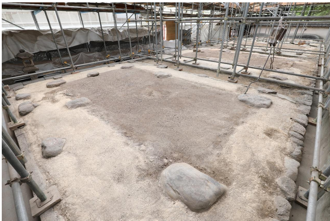
基礎の様子（北東・背面側より）
