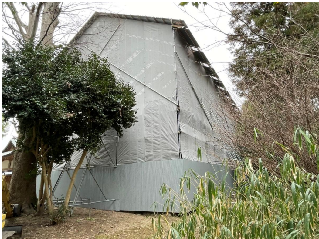
素屋根 全景（北東より）
