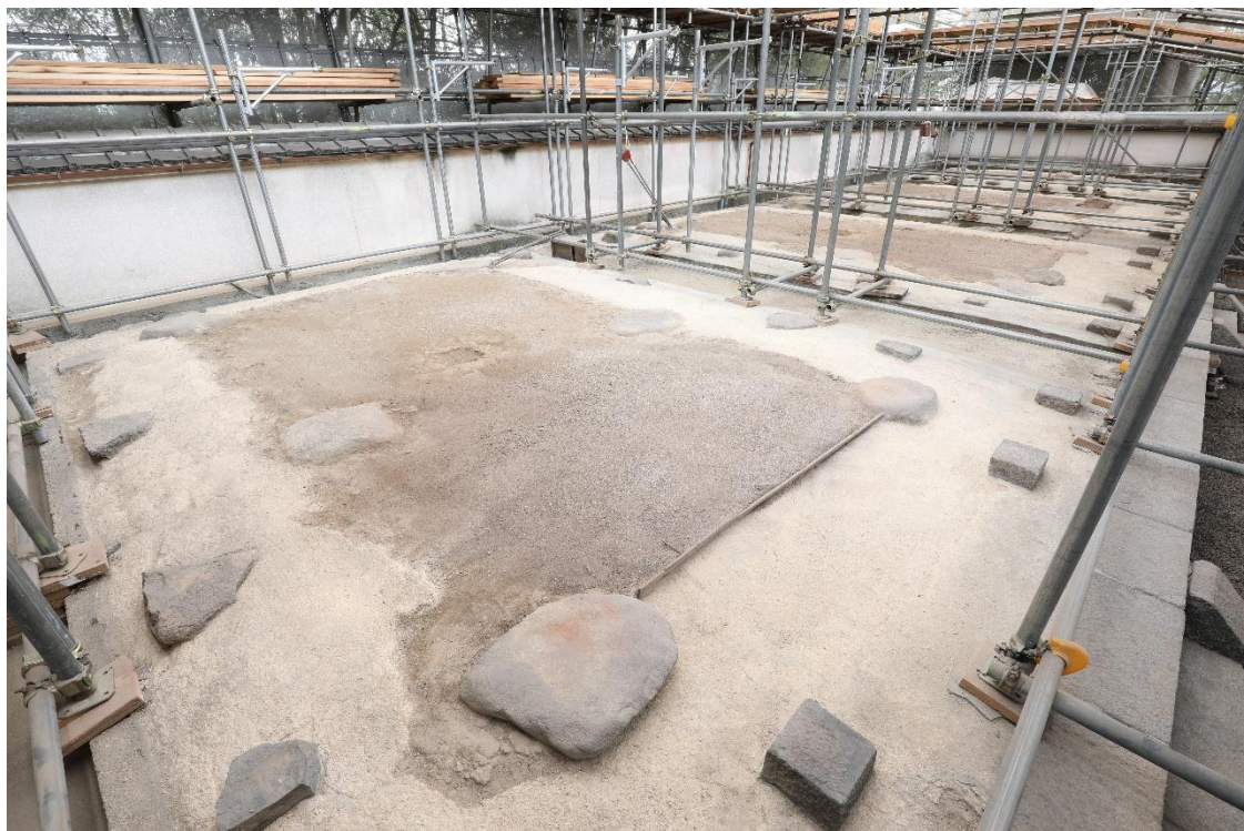
基礎の様子（南西・正面側より）
