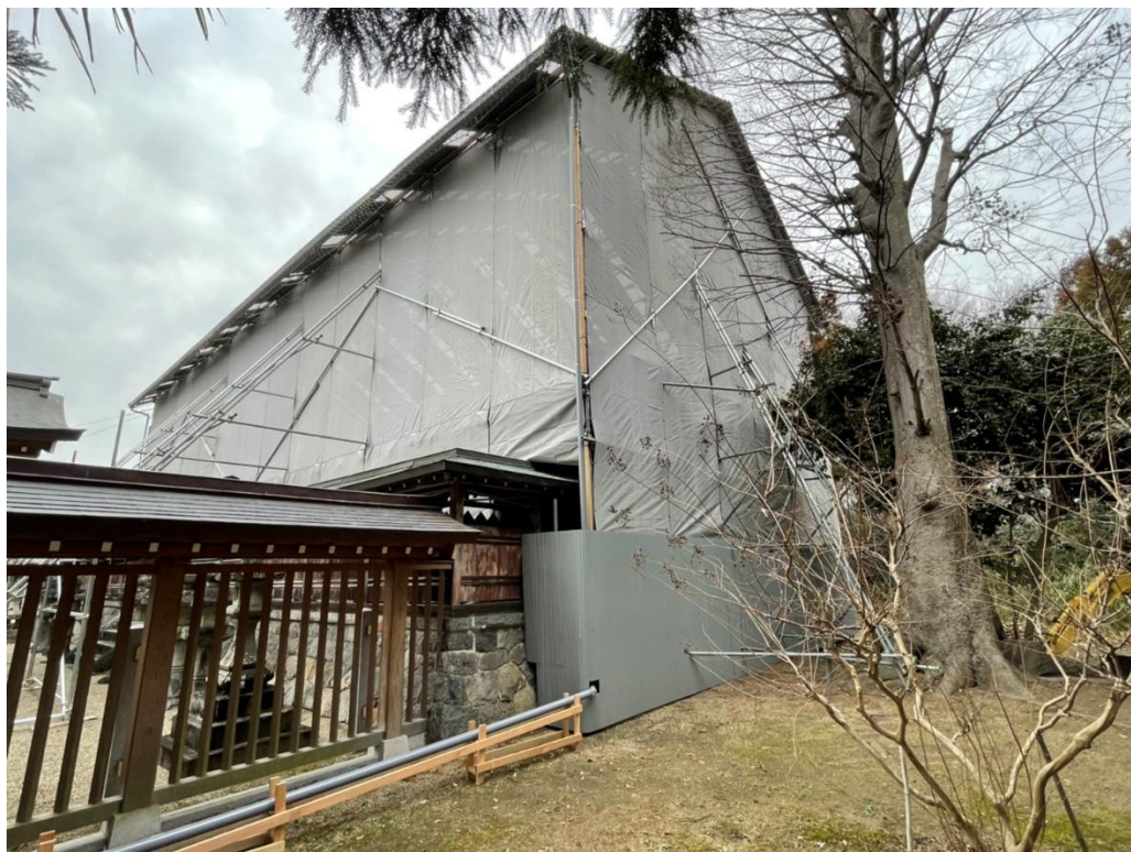
素屋根 全景（南東より）
