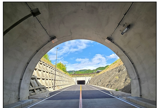
高取トンネル内から見た上辻トンネル
