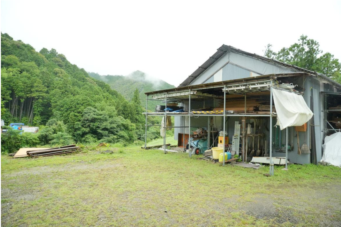
工事予定箇所（北より）
