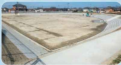
馬見川左岸流域貯留施設（広陵町） 貯留量 7,500 m
