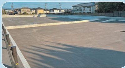
法隆寺北流域貯留施設（斑鳩町） 貯留量 4,500 m
