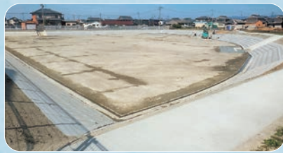
馬見川左岸流域貯留施設（広陵町） 貯留量 7,500 m 3
