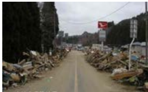
瓦礫・土砂等の除去
