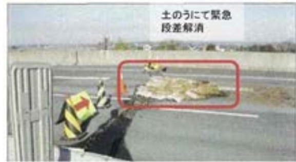
橋梁段差の解消
