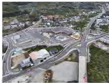
道の駅「海南サクアス」
