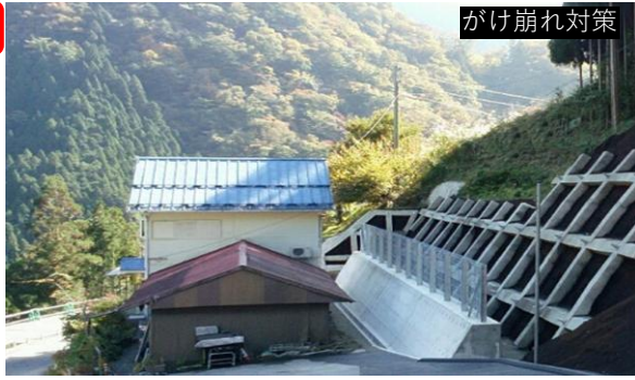
急傾斜地崩壊対策施設 殿野(五條市)
