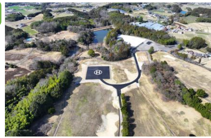
南部中核拠点: 先行整備工事完了
