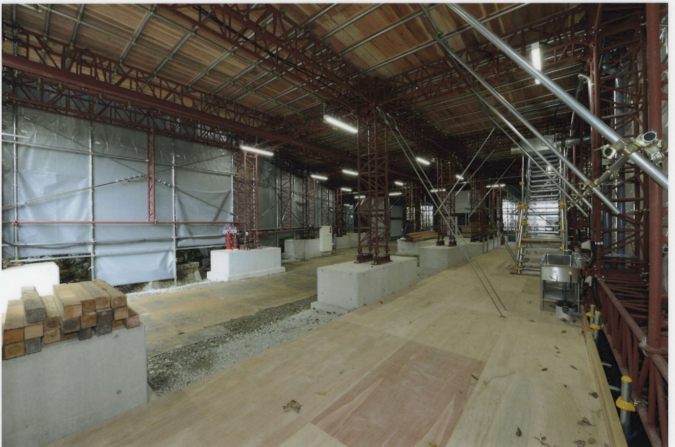
作業場1階(二王門GL)
