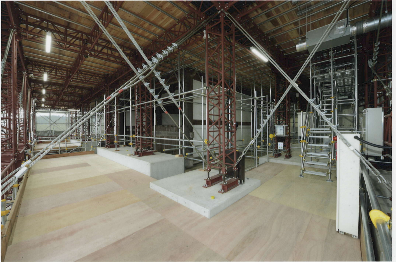
素屋根1階(二王門GL)
