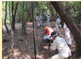
植生保護柵の設置
