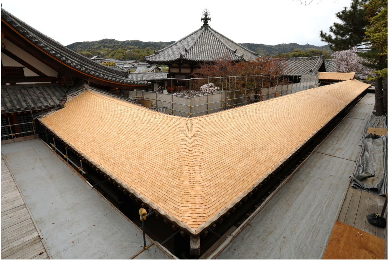
重要文化財法隆寺東院廻廊 東廻廊 土居葺状況 東南より
