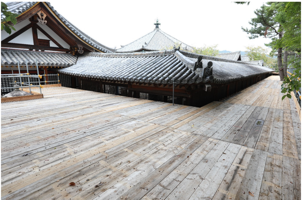
重要文化財法隆寺東院廻廊 東廻廊 屋根瓦葺修理前状況 東南より
