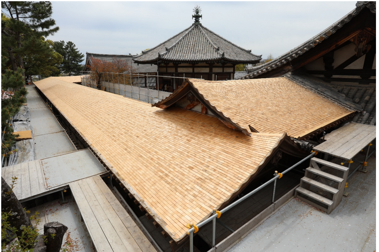
東廻廊 屋根土居葺状況 東北より
