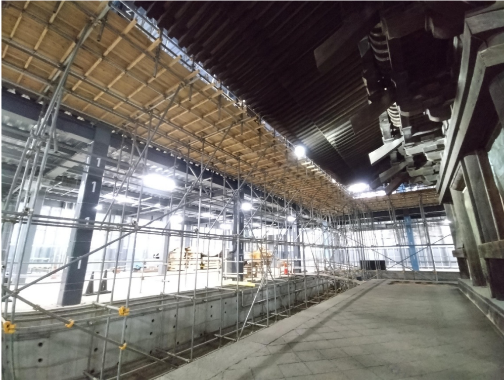
国宝 興福寺五重塔 軒足場 初層 西から
