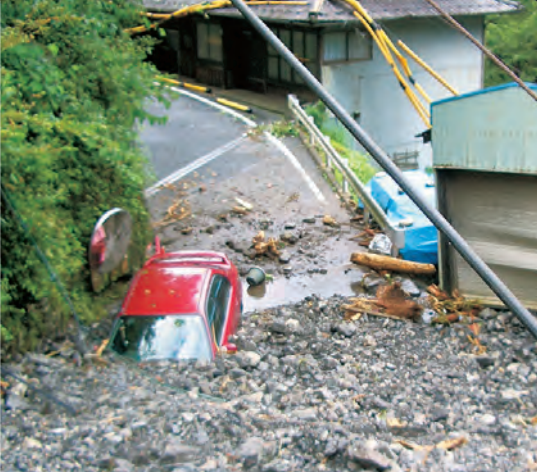
平成23年紀伊半島大水害 (五條市大塔町辻堂地区 土石流)
