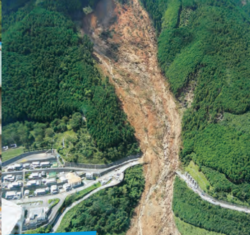
平成23年紀伊半島大水害 (川上村迫地区 国道169号寸断)
