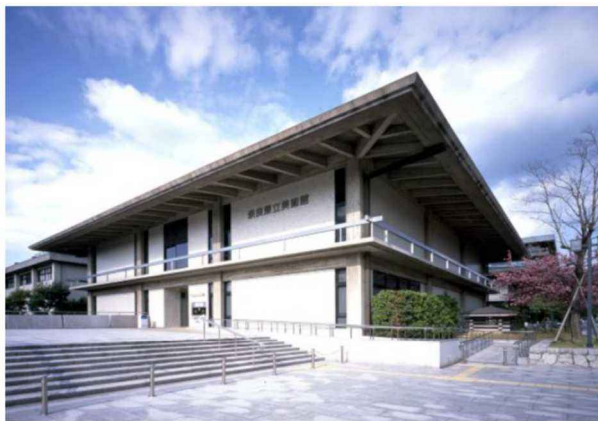
外観（正面エントランス）
