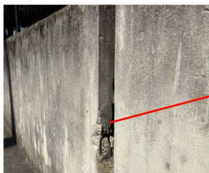
◀鉄筋が露出（トラックヤード）
