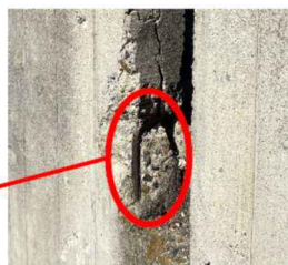
◀鉄筋が露出（トラックヤード）
