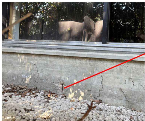
◀鉄筋が露出（基礎部分）
