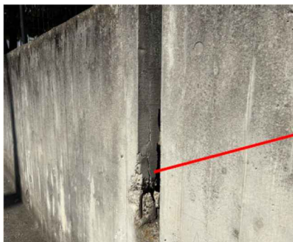
◀鉄筋が露出（トラックヤード）
