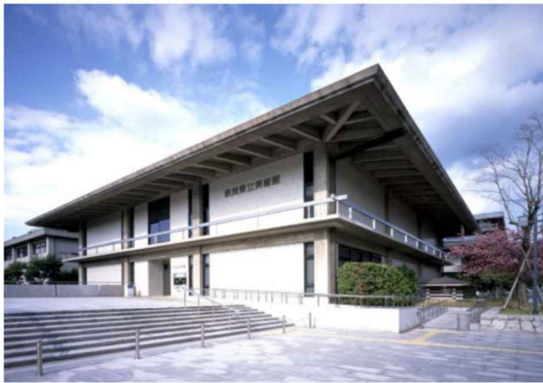
外観（正面エントランス）
