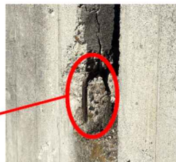
◀鉄筋が露出（トラックヤード）
