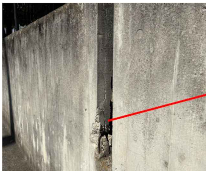
◀鉄筋が露出（トラックヤード）
