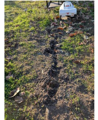
電線ワイヤーの設置作業
