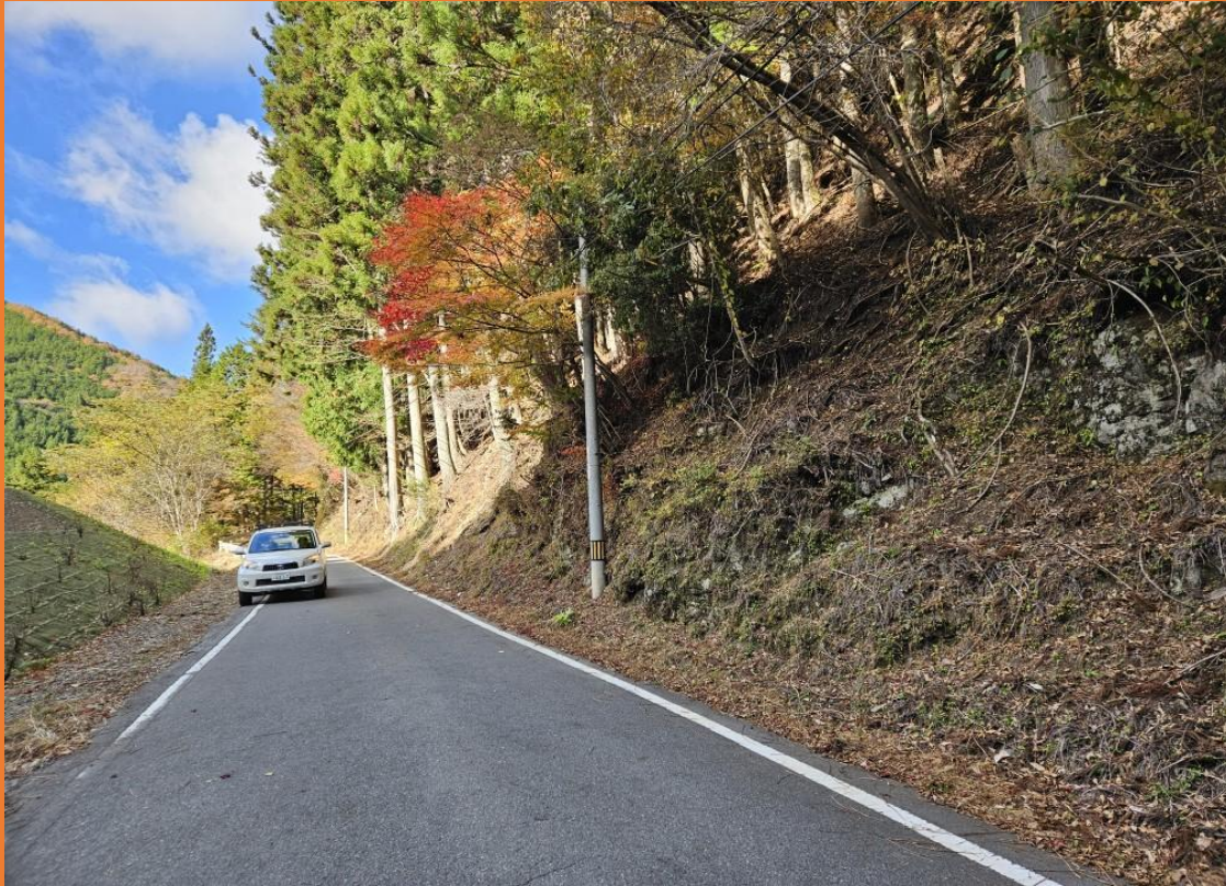
支障木伐採前
