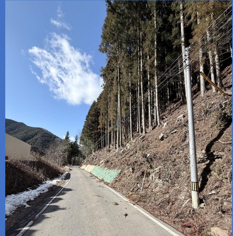
支障木伐採後
