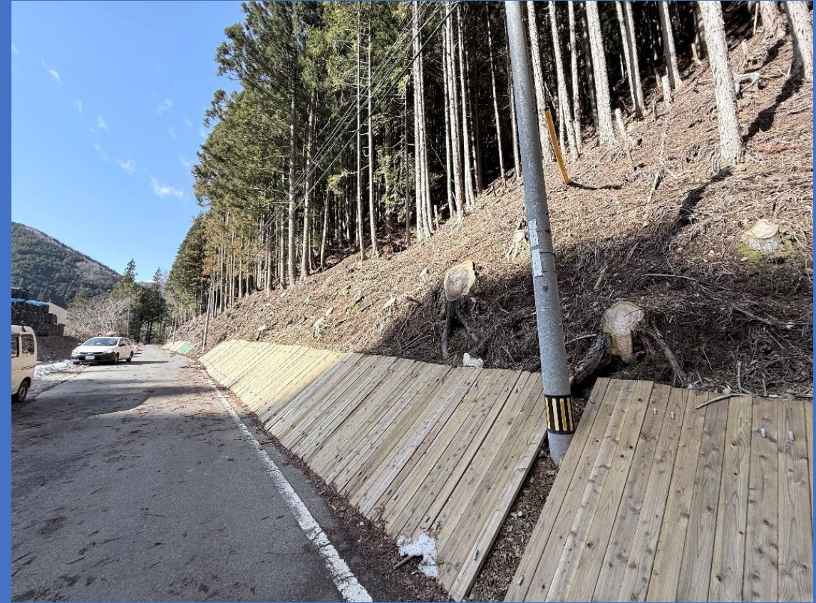
支障木伐採後
