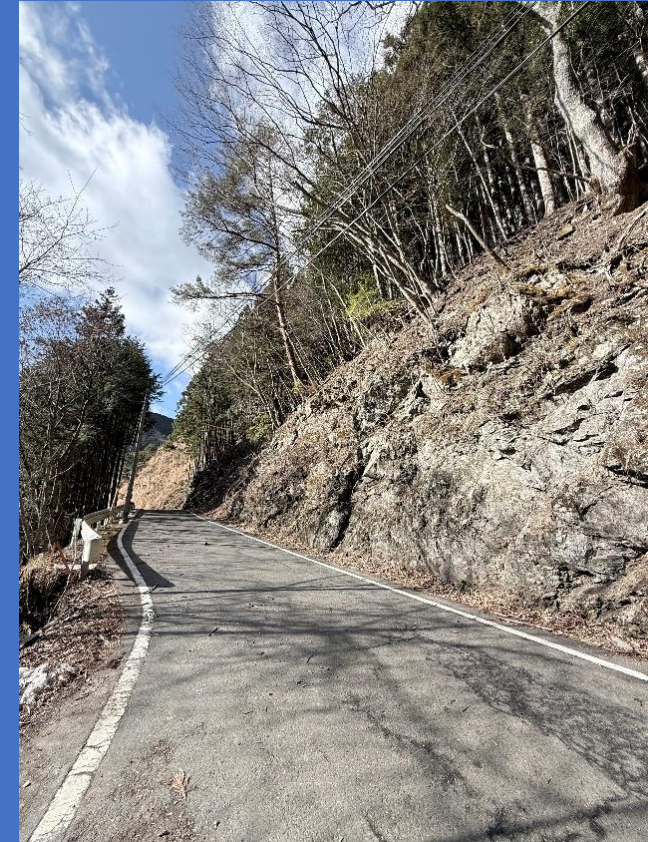
支障木伐採後
