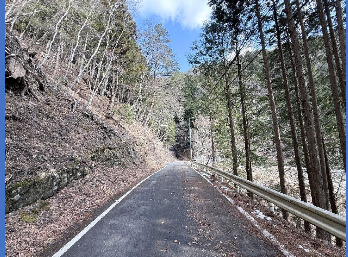
支障木伐採後
