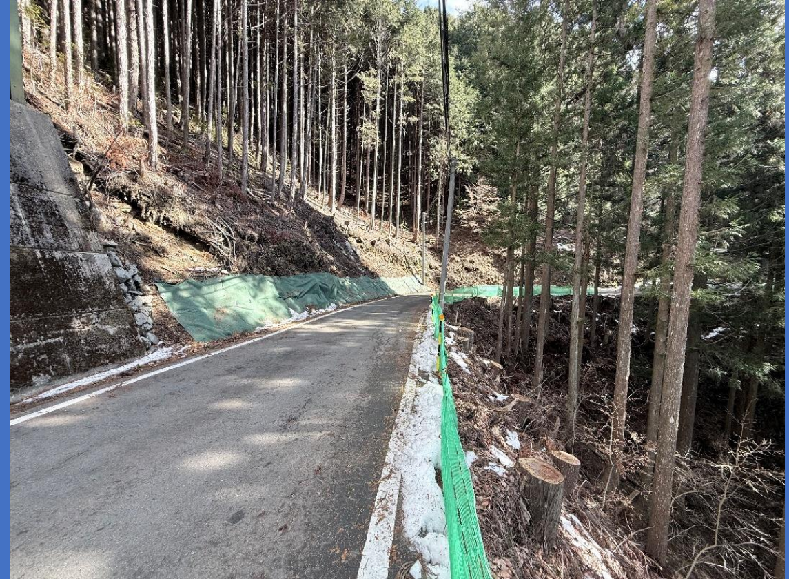
支障木伐採後
