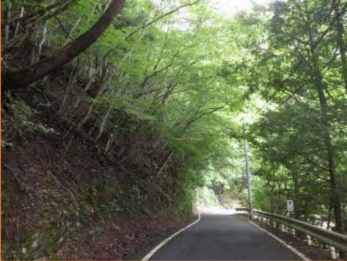
支障木伐採前
