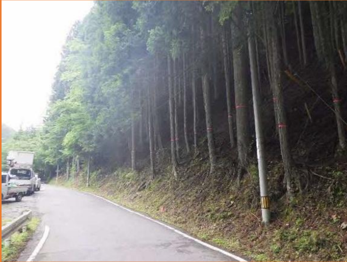
支障木伐採前
