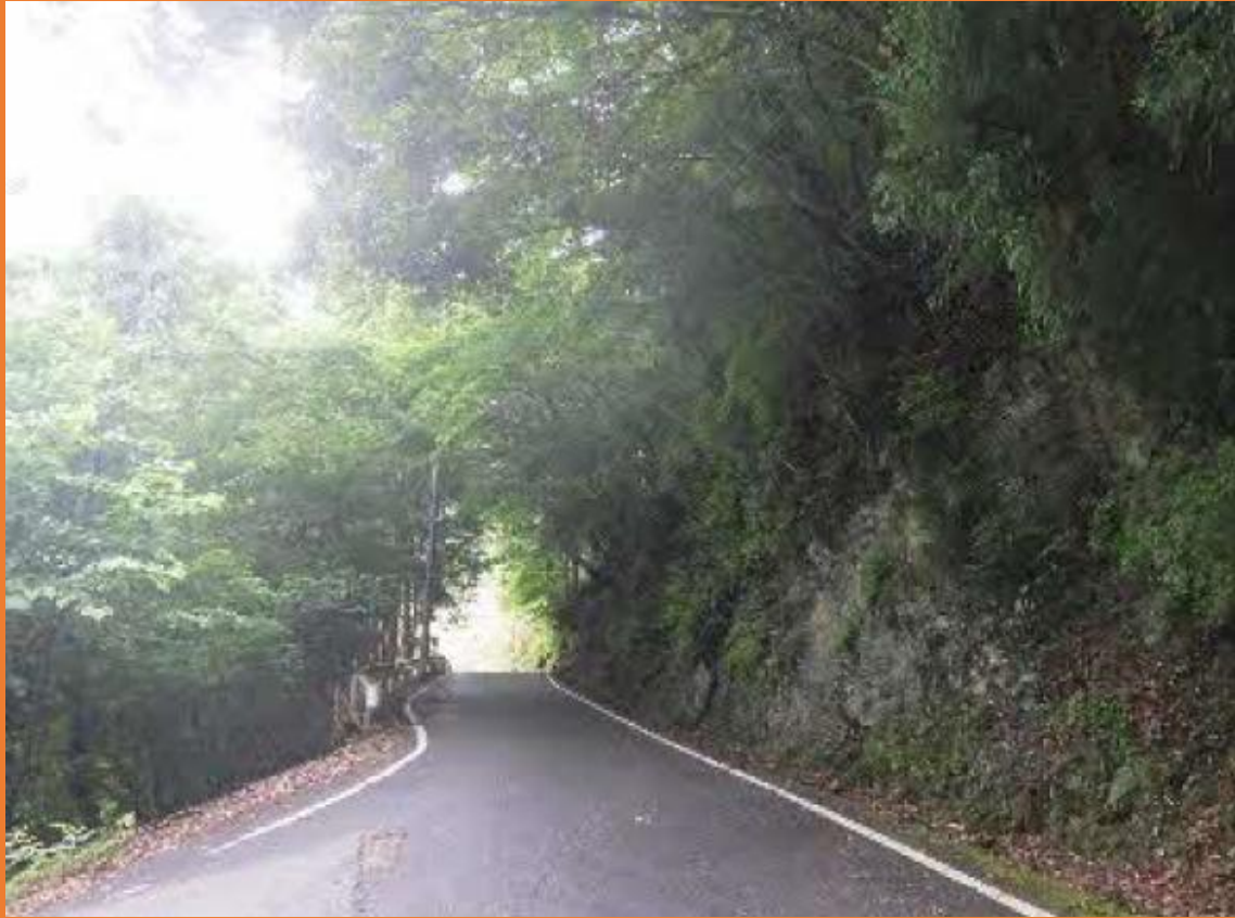
支障木伐採前
