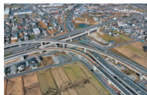
橿原高田IC(大阪方面接続ランプ)
