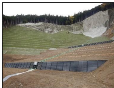
山地災害を復旧した箇所
