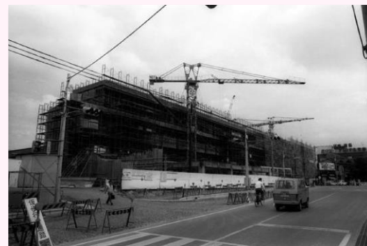
オークタウン建設中（昭和50年）
