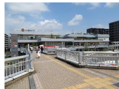
近鉄大和高田駅前フラワーデッキ
