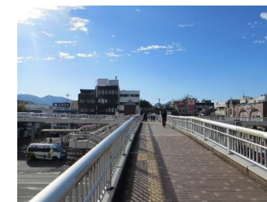
近鉄大和高田駅前フラワーデッキ
