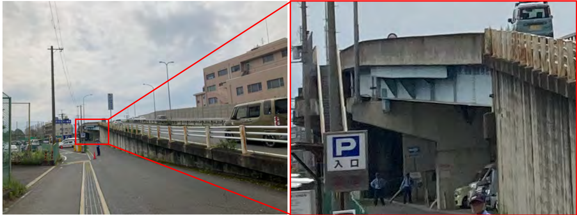
写真 バイパス側道とバイパス下道路の現況
