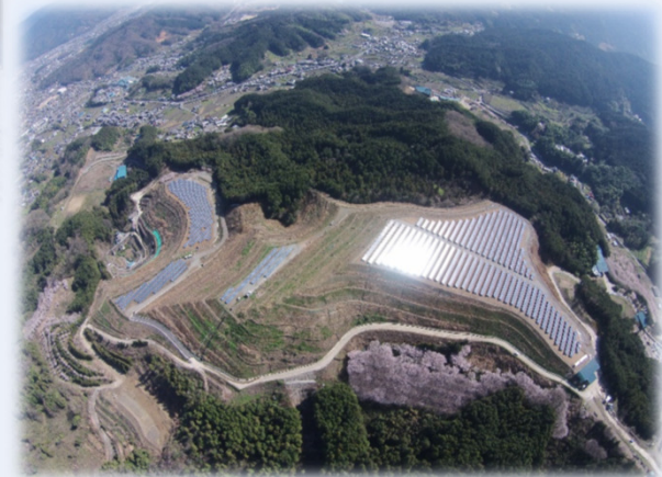
太陽光発電施設
