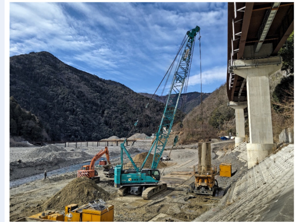
熊野川 護岸工事
