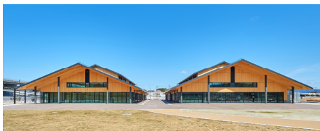
道の駅クロスウェイなかもち新築工事
