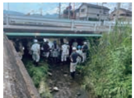
▲県が研修を開催し、市町村職員が専門家から目視検査の着眼点の説明を受けている様子
