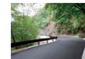
▲1.5車線の道路整備(国道309号[R7.7供用])
