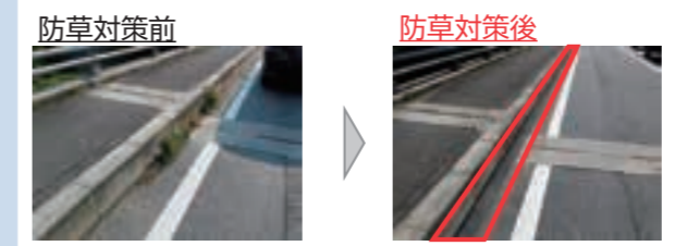
▲防草シールを使用した防草対策 令和7年度 防草対策工事 完了箇所(国道166号 葛城市太田)
