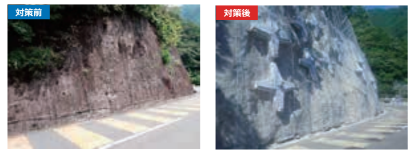
▲コンクリート吹付及びアンカー工による法面対策 (国道168号 十津川村川津)
