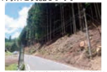
▲県道川津高野線での実施状況(野迫川村)
