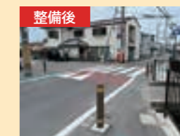
▲スムーズ横断歩道の整備
