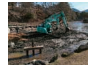
▲鷺池の浚渫作業
