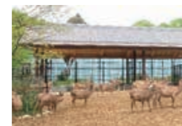
▲鹿の給餌施設
