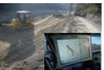
▲ICT建設機械による施工
