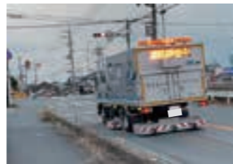
▲管路上部の空洞調査
