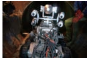
▲自走式カメラによる管内調査
