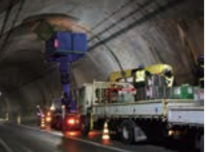
(一般国道168号 小代下トンネル)
