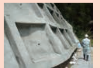
▲現場確認の様子
