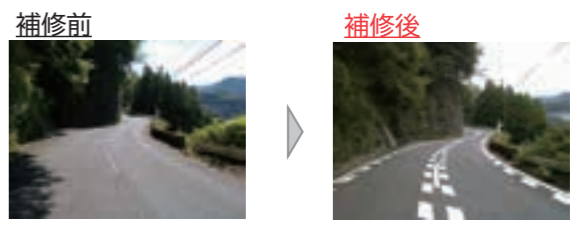
▲消えかけた区画線の修繕 令和7年度 区画線補修工事 完了箇所(国道169号 下北山村上池原)
