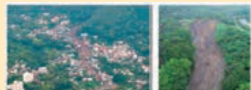
▲大雨に伴って盛土が崩落し土石流が発生 (R3. 7静岡県熱海市)
