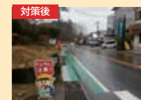
▲路側帯のカラー舗装(国道309号 大淀町下瀬)
