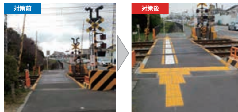
▲踏切道部における視覚障がい者誘導表示の設置(奈良大和郡山斑鳩線 大和郡山市北郡山町)
