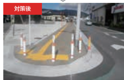
▲歩道を設置することで、児童の歩行空間を確保(国道168号 生駒郡平群町吉新)
