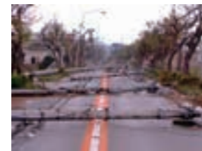
▲台風で倒壊した電柱が道路を塞いでいる (出典:国土交通省ウェブサイト)
