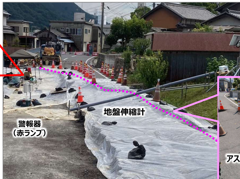
地盤伸縮計の設置状況
