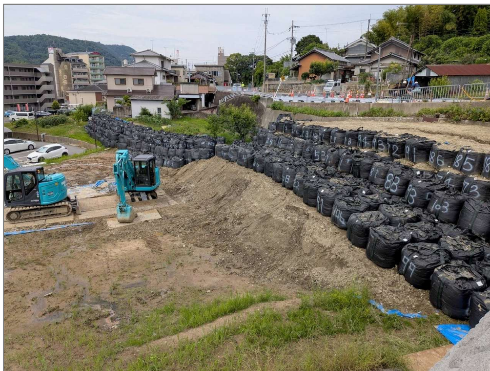
道路下に大型土のうを設置している状況
