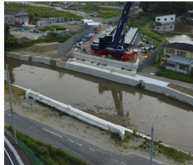
新小平尾橋 架設前(令和7年5月)
