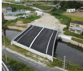
架設後(令和7年11月)
