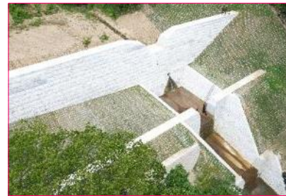
砂防堰堤(令和4年8月完成)
