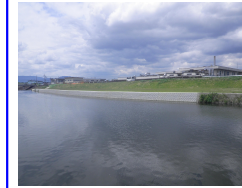
現場状況(令和7年4月) (護岸整備実施中)
