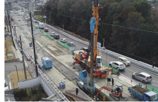
立体交差化整備中(天理町交差点から東向き) (令和8年3月)
