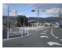
歩道整備(令和5年12月完成)
