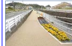
遊歩道(令和4年12月完成)
