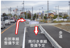
現場状況(令和5年11月) (右折車線整備実施中)
