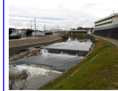
現場状況(R8年3月) (護岸整備実施中)
