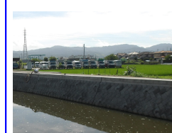
現場状況(令和8年3月) (護岸整備実施中)
