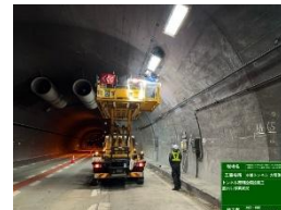
国道309号（水越トンネル）
