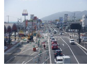
工事中の状況（香芝市旭ヶ丘1丁目付近）
