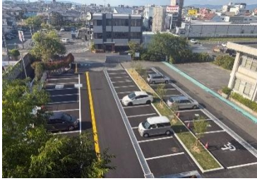
甘田川貯留施設の完成状況（大和高田市栄町）
