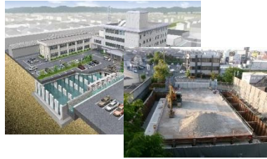
甘田川貯留施設完成イメージと工事中の写真（大和高田市栄町地区）
