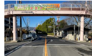
国道166号 舗装修繕工事
