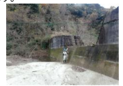
林沢溪流（御所市林） 砂防堰堤の堆砂状況確認
