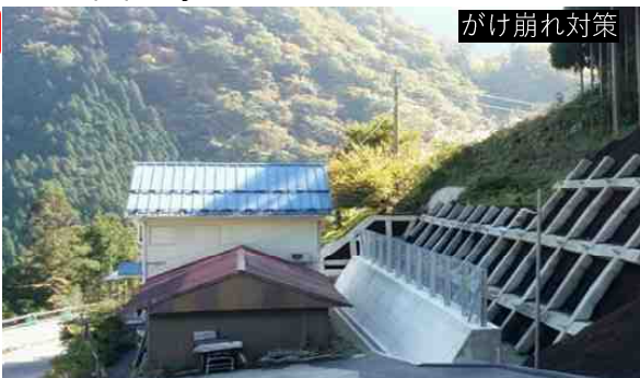
急傾斜地崩壊対策施設 殿野(五條市)
