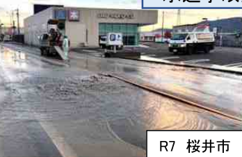
水道事故発生状況
