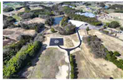
南部中核拠点: 先行整備工事完了
