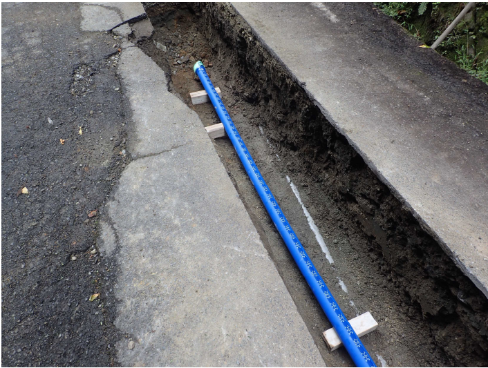
（耐震管の管路更新）
