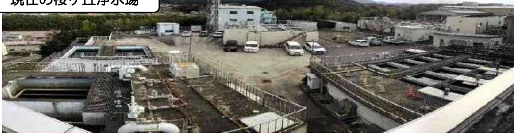
現在の桜ヶ丘浄水場
