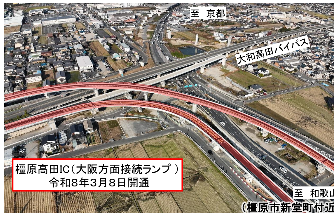
京奈和自動車道 大和御所道路(5工区)
