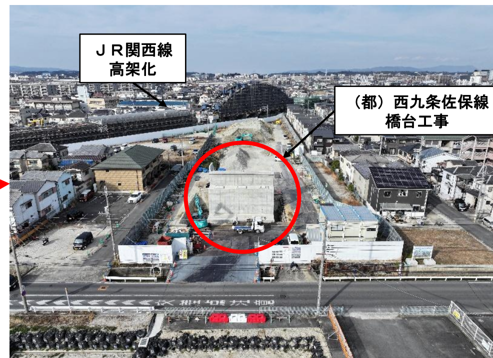
J R関西本線・(都)西九条佐保線 施工状況 (①の視点から)
