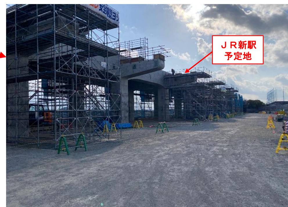
J R新駅 施工状況 (②の視点から)
