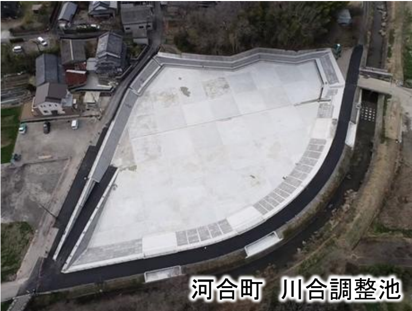
○雨水貯留施設整備事業
