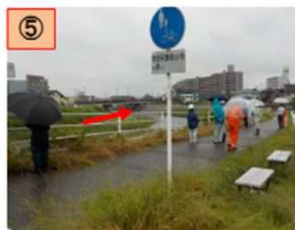
⑤宇都宮土木の点検状況(5/29) 一級河川田川(宇都宮市錦)
