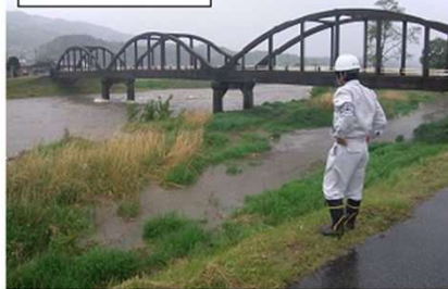
河川巡視(出水時)
