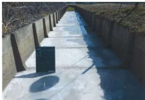
底張コンクリート
