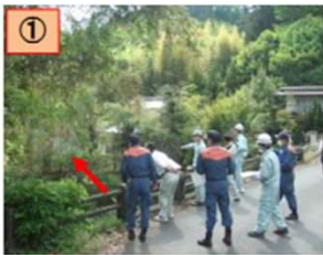
①大田原土木の点検状況(5/10) 一級河川押川(大田原市須賀川)
