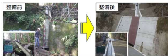
山城大野 地すべり水路 (三好市)
