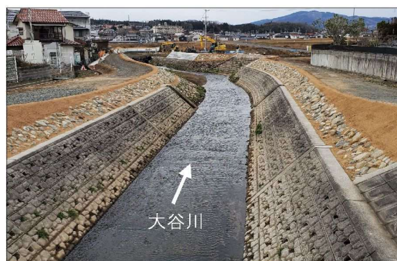
広島県による支川の改修
