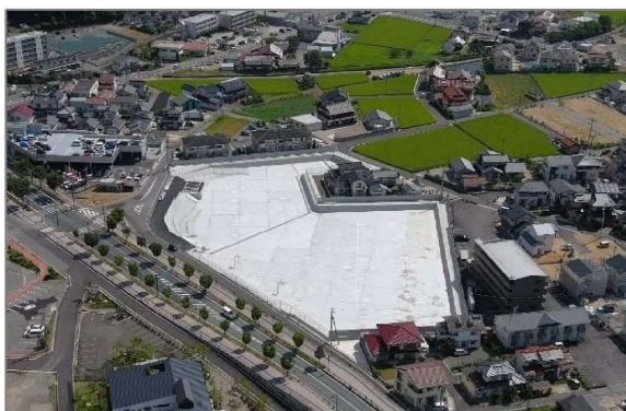
三次市による雨水貯留施設の整備
