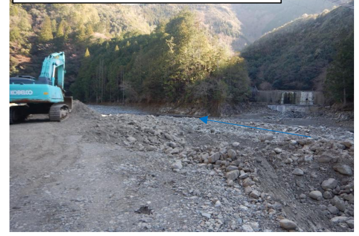
工事後(R7年度実施箇所(工事中))
