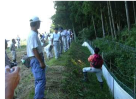
共同作業による侵入防止柵設置作業
