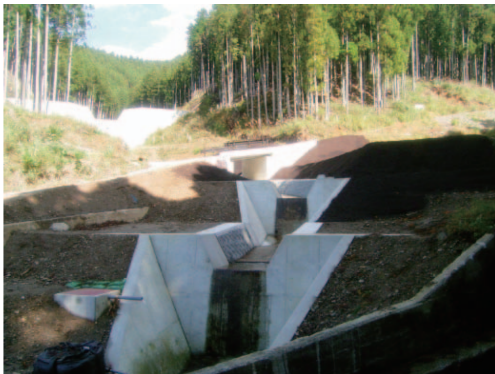
土屋原地区土石流対策(御杖村)
